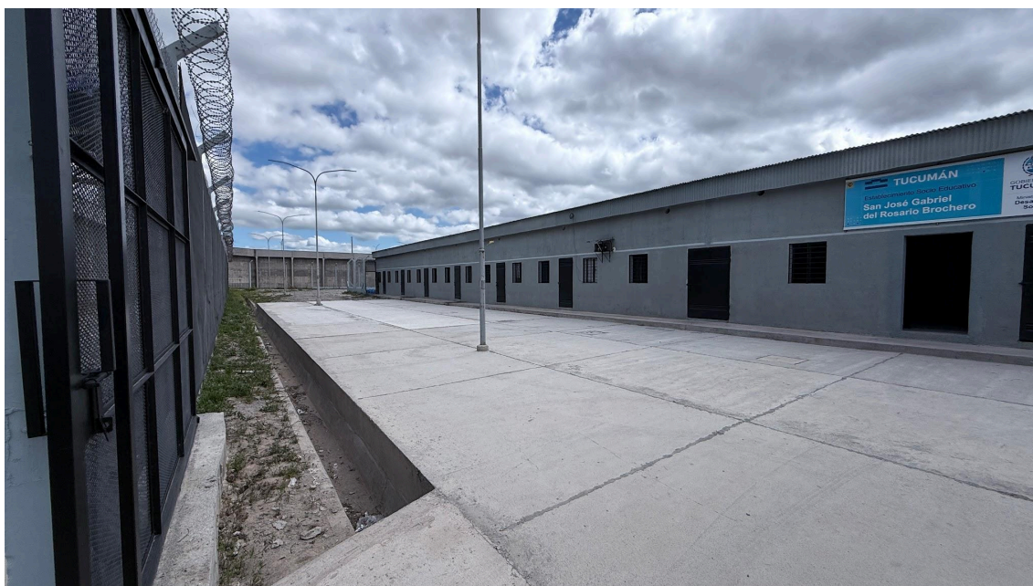
► Foto del Ingreso al Pabellón No. 8 con vista al cardinal este
